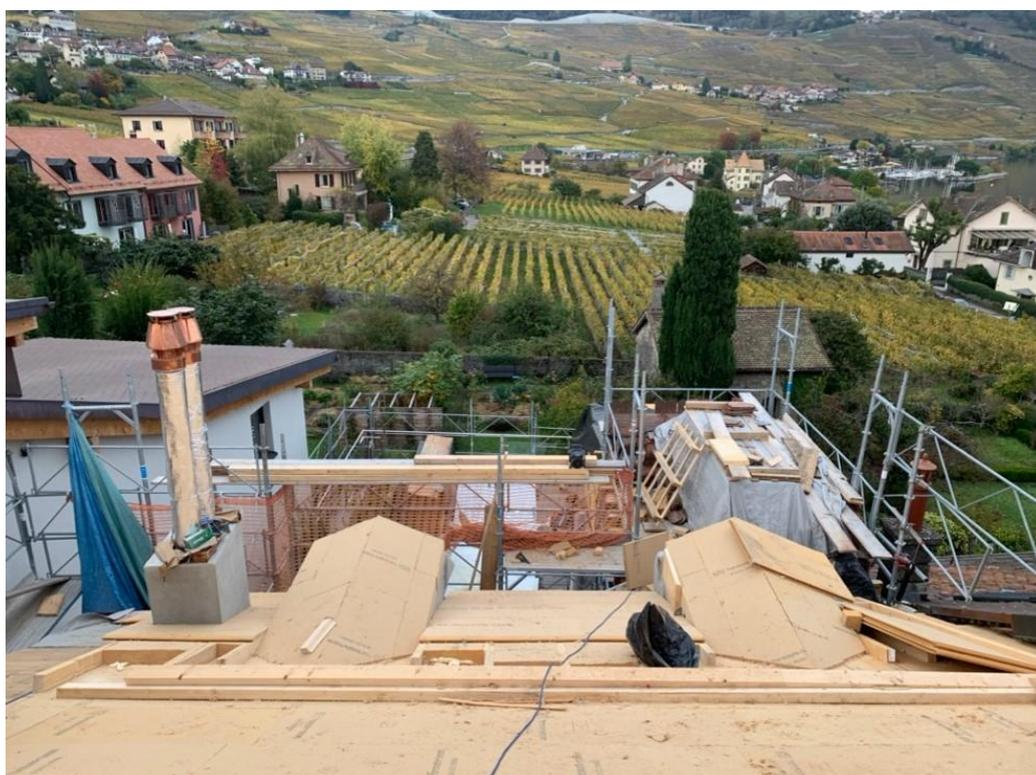
*Réfection et isolation de la toiture dans le bourg de Cully © LR Architectes, 2024.*
