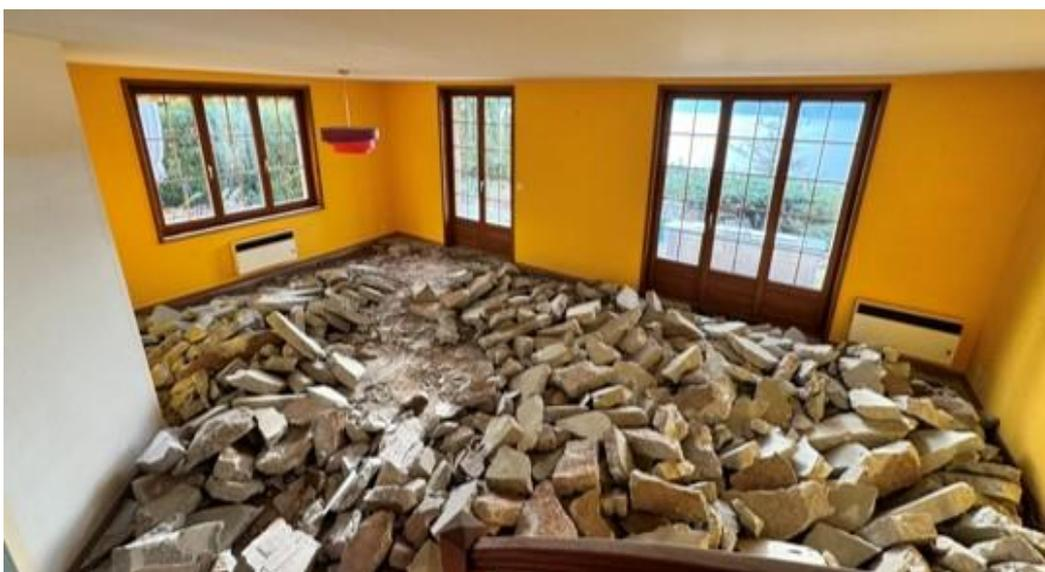
*Démolition de la chape pour la mise en place d'un chauffage au sol, Grandvaux, 2024.*
